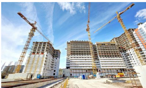
Строительство жилья, производство строительных материалов
