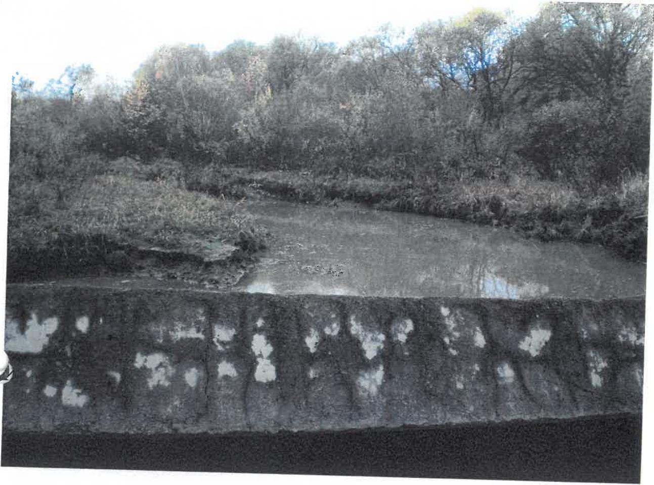
**Вывод комиссии:** Для обеспечения водопропуска и обеспечения движения транспортных средств через ручей необходимо произвести расчистку русла ручья от железобетонных конструкций, устройство водопропускной трубы. Для определения оптимального сечения водопропускной трубы необходимо обратиться в проектную организацию.
