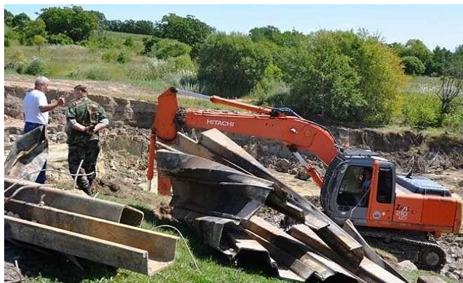
Контроль хода выполнения плана аварийно-восстановительных работ
