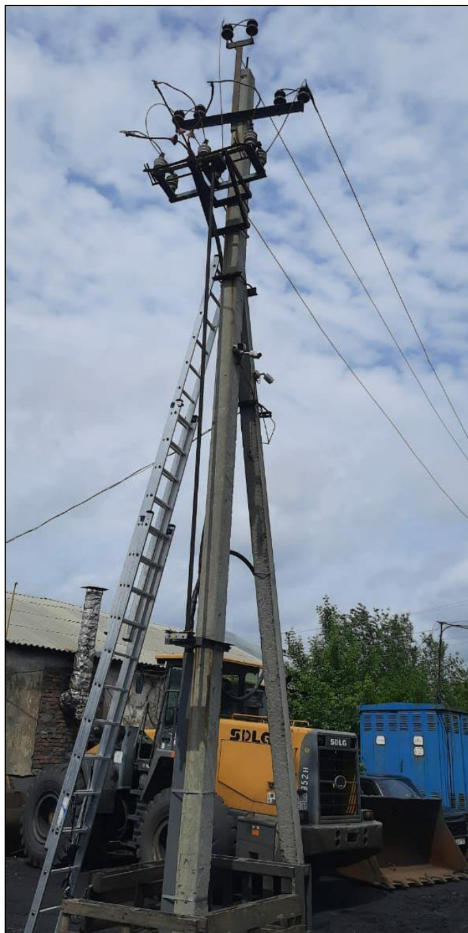
Опора № 7/1 воздушной линии электропередачи 6 кВ Л-815
