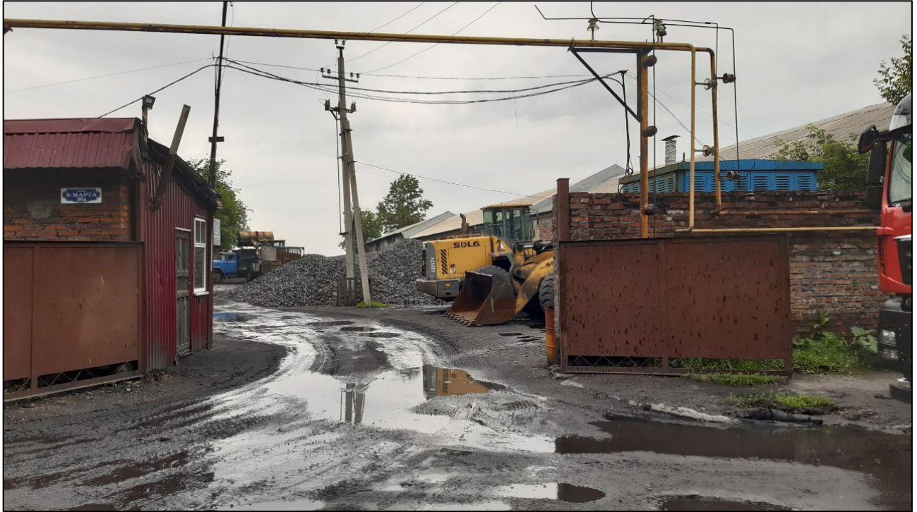
Опора № 7/1 воздушной линии электропередачи 6 кВ Л-815
